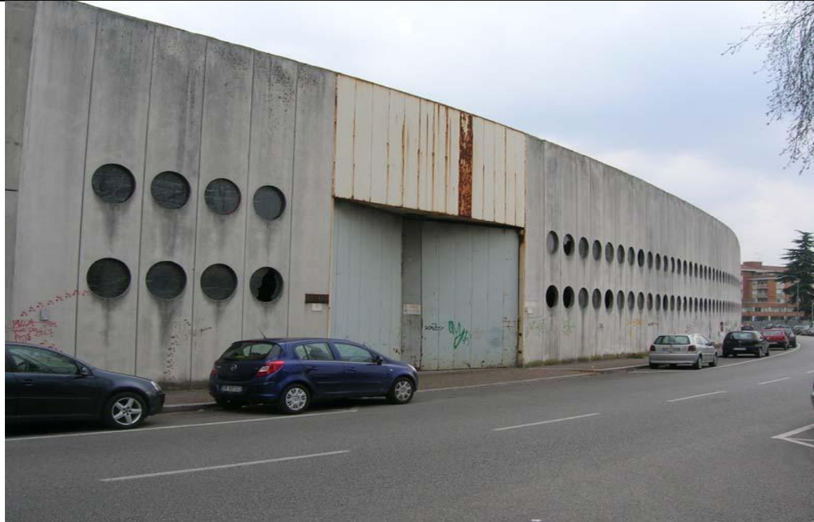
2 η Εικόνα: Κατάσταση του κτιρίου πριν την παρέμβαση
