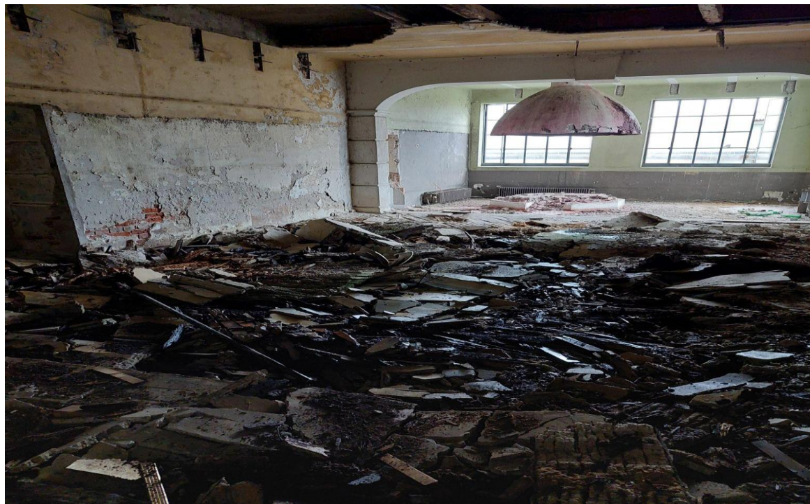
3 η Εικόνα: Κατάσταση του εσωτερικού του κτιρίου πριν την παρέμβαση
